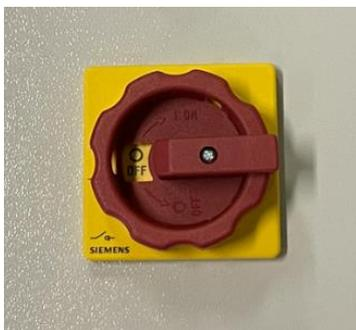
**Achtung!** Vor der Benutzung der Notbetätigung muss der Hauptschalter auf „OFF“ gedreht werden. Die Notbetätigung darf nur bei stehendem Motor erfolgen!
