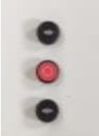
Zum **Öffnen** des Tores den Taster „AUF“ drücken: Das Tor öffnet bis zur Endposition
